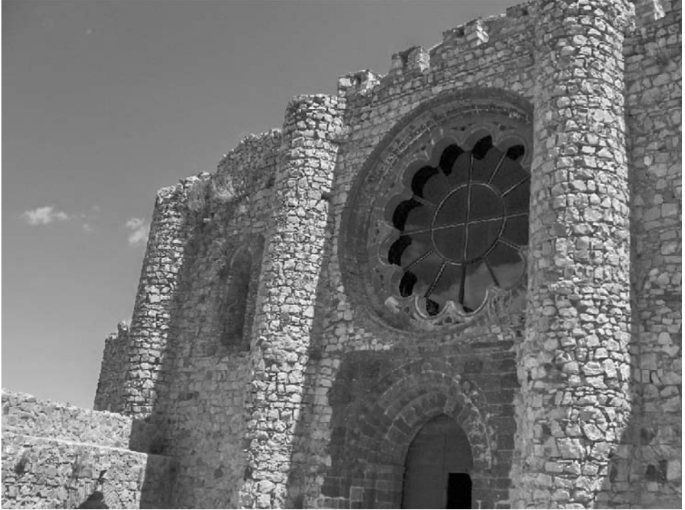
Figura 2. Entrada de la Iglesia del Conventual de Calatrava la Nueva. A la izquierda, los muros de la capilla de Diego García del Castrillo.
